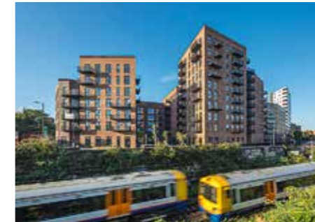
Dalston Works, världens största träbyggnad i London, Storbritannien.
